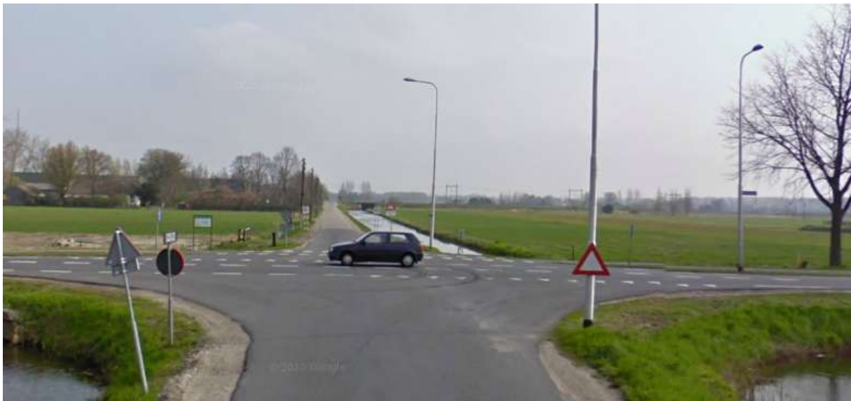
Zuidelijke Dwarsweg vanuit zuidwestelijke richting (oude situatie)
