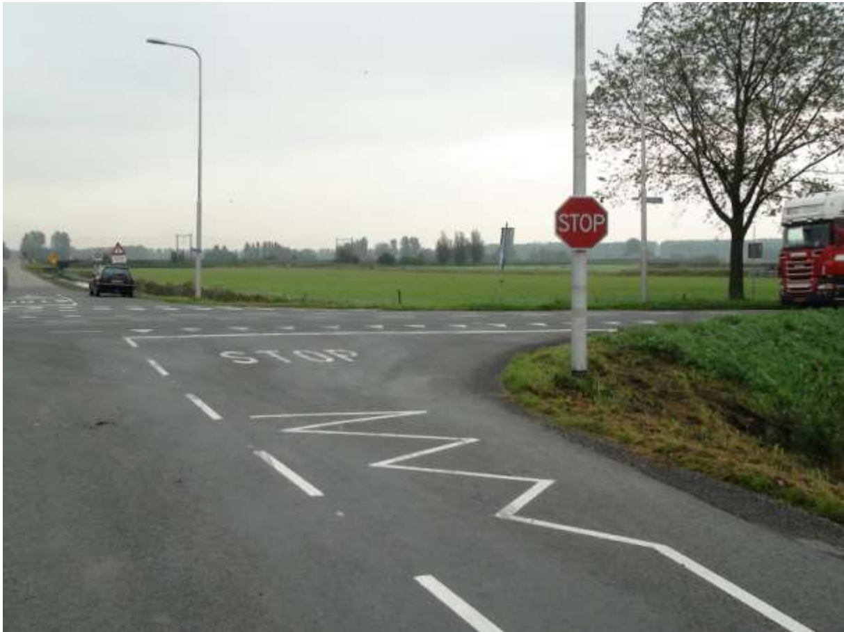
Zuidelijke Dwarsweg vanuit zuidwestelijke richting (huidige situatie)
