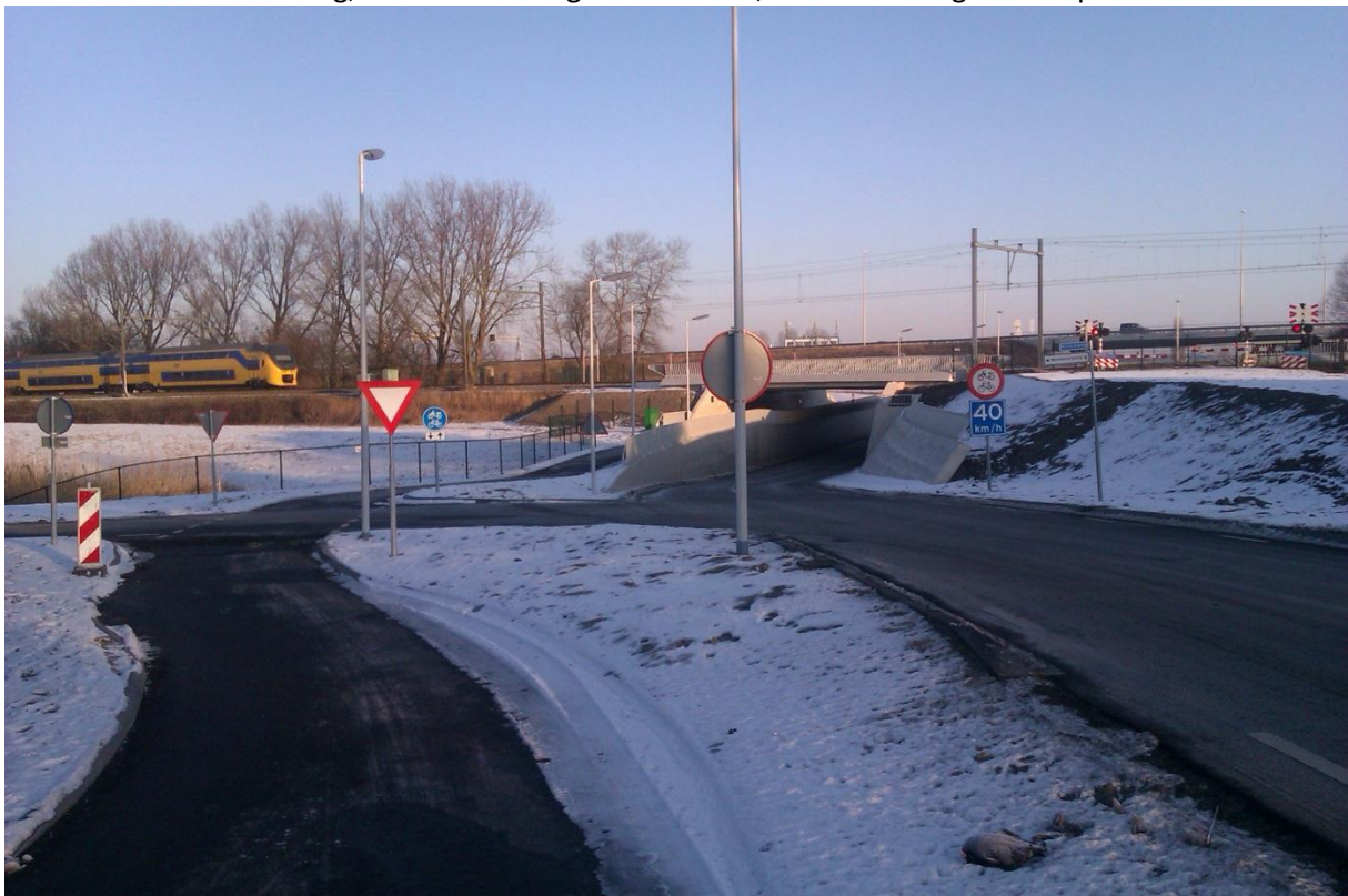
Beeld richting spoortunnel vanuit de richting Zevenhuizen (Zuid) naar Moerkapelle (Noord)
